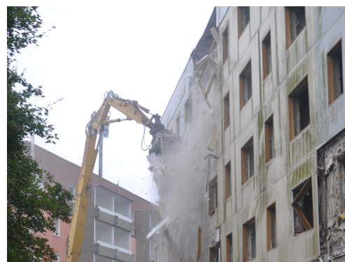
Rückbau eines Wohnblocks im Gebiet
